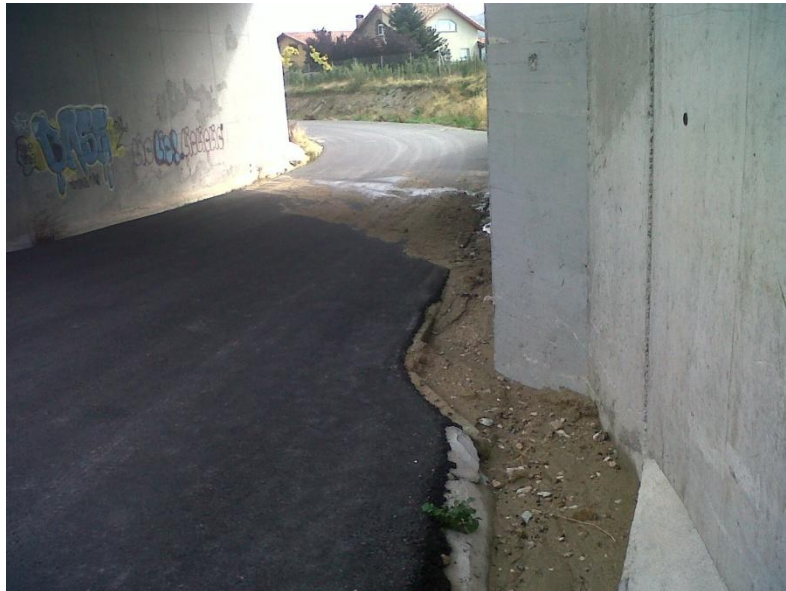
Imagen del camino en el sentido de bajada
