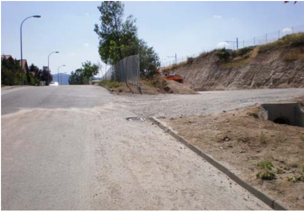
Entrada a la nueva pista desde calle Molineras (1)
